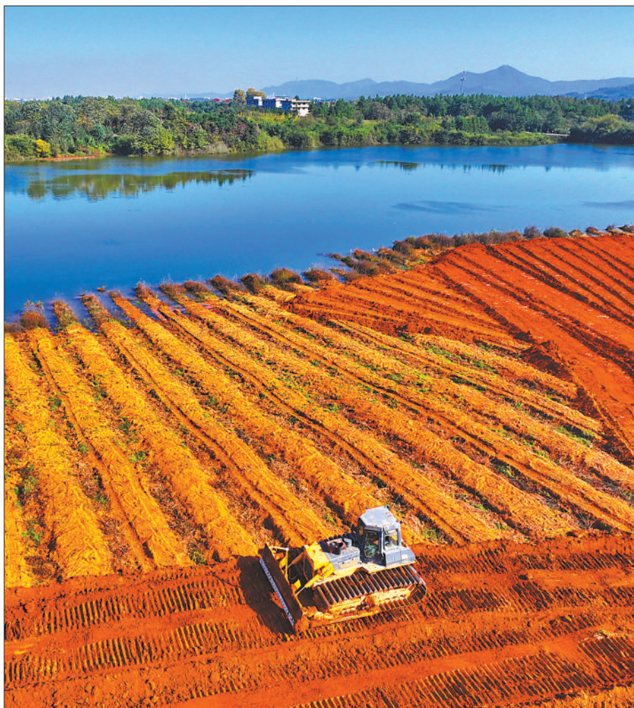
江西省抚州市东乡区虎圩乡高标准农田建设点,农机手驾驶推土机进行耕作层表土剥离。
