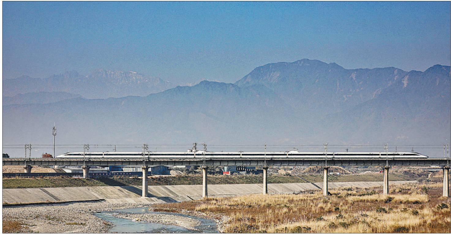
图为首趟川青铁路动车组从绵竹市绵远河大桥驶过。
