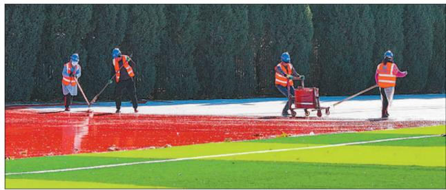
左图:11月23日,工人在长沟中学操场进行塑胶跑道弹性层施工。以上图片均为宋涛摄
