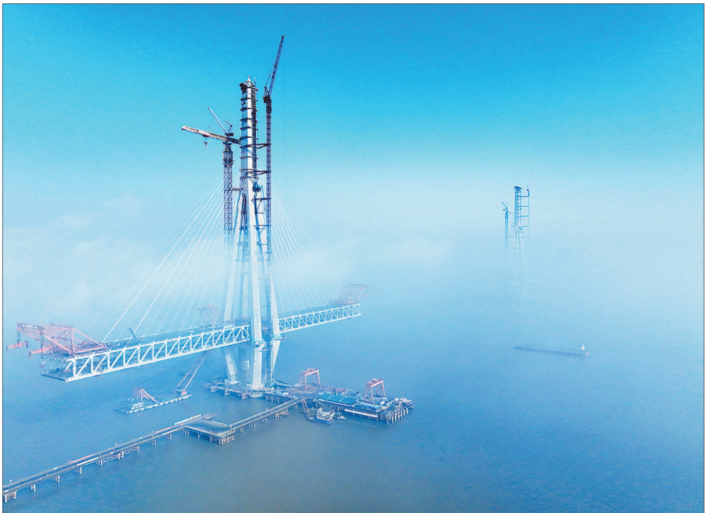
11月27日，江苏省常州市，常泰长江大桥施工现场云雾缭绕，蔚为壮观。据了解，常泰长江大桥是长江经济带综合立体交通走廊的重要项目。大桥连接常州市与泰州市，是一座集高速公路、城际铁路和普通公路为一体的过江通道。 陈 曦摄（影像中国）
