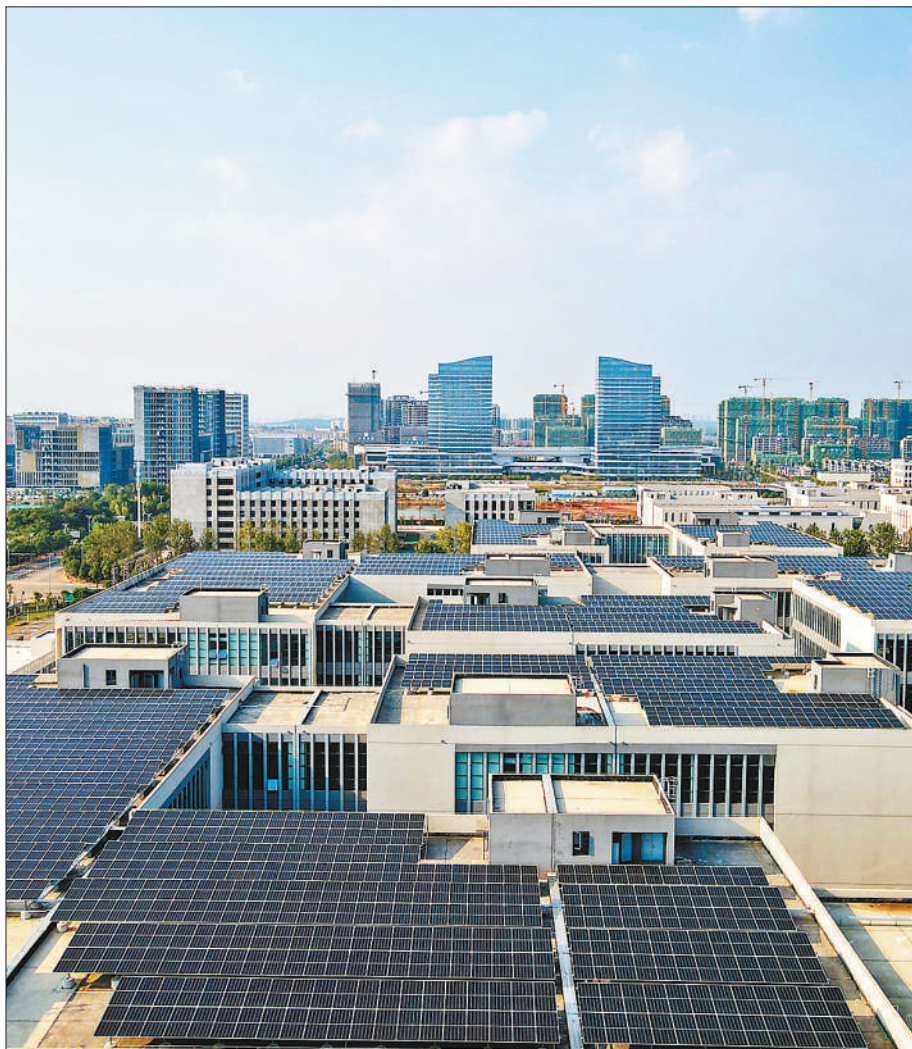
江西赣江新区中医药科创城创新示范基地，建筑顶部安装着太阳能光伏组件。
