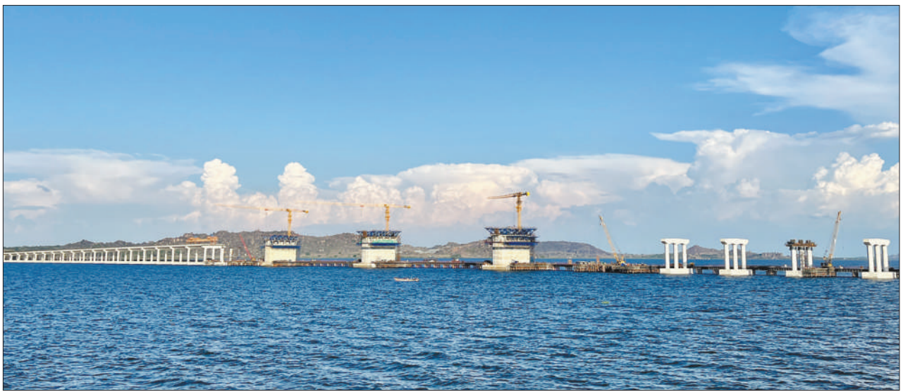
由中国土木工程集团有限公司承建的坦桑尼亚马古富力大桥位于坦桑尼亚维多利亚湖南岸,建成后将成为非洲最长矮塔斜拉桥。该桥和当地重要公路干线连通,将带动周边区域经济发展。图为项目在进行主桥悬灌梁及矮塔施工。 芦旭摄
