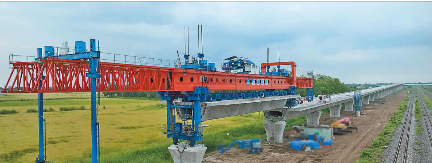
作为中泰共建“一带一路”的旗舰项目及泰国首条标准轨高速铁路,中泰铁路采用中国标准设计建造,一期工程连接曼谷和呵叻,二期工程将延伸至东北边贸重镇廊开,实现与中老铁路衔接,将大幅度缩减人员流动时间与物流成本。
