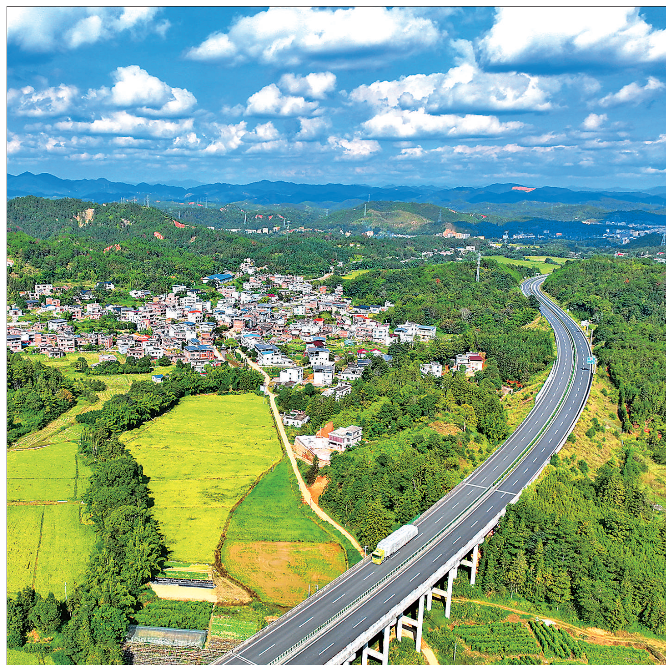
11月15日,江西省赣州市定南县,宁定高速(定南段)穿村而过,沿线农房坐落于青山之中,美景怡人。近年来,定南县不断完善交通基础设施,高速公路、国道、省道、村村通公路日趋完善,城乡居民出行、农产品运输更加便捷。朱海鹏摄(影像中国)
