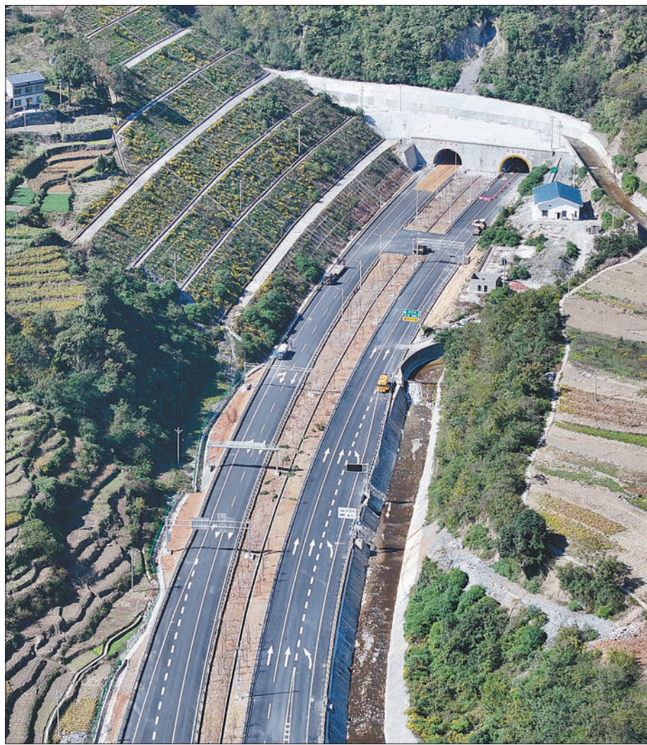
巫镇高速公路三标段施工现场。
