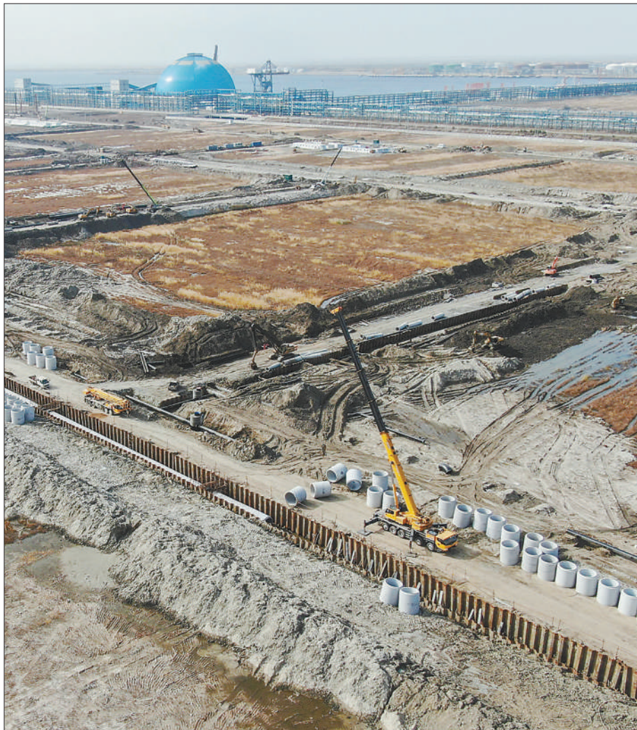
辽宁盘锦，华锦阿美精细化工及原料工程项目正有序施工。
