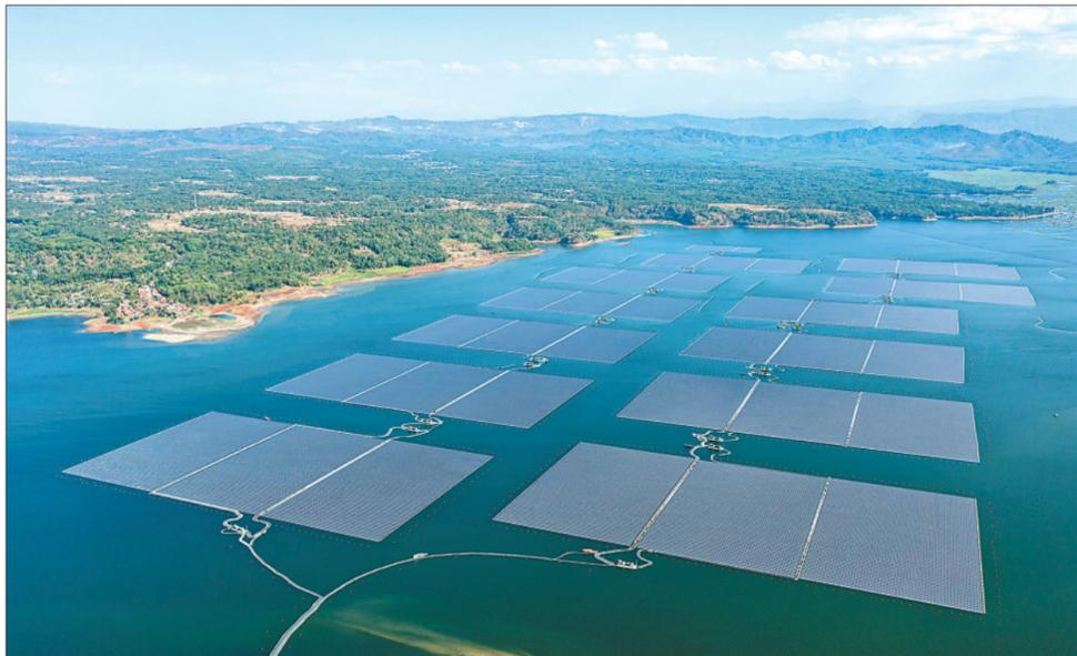
由中企承建的漂浮光伏项目11月9日在印度尼西亚西爪哇省芝拉塔水库实现全容量并网发电。印尼总统佐科出席并网发电仪式。据了解，项目总装机容量为192兆瓦，光伏场区总覆盖面积约250公顷。项目预计能够为当地每年节约标煤11.7万吨，每年减少二氧化碳、二氧化硫、氮氧化物排放量分别为21.4万吨、0.9万吨和4500吨，可为约5万户家庭提供清洁能源。图为芝拉塔项目光伏阵列。
