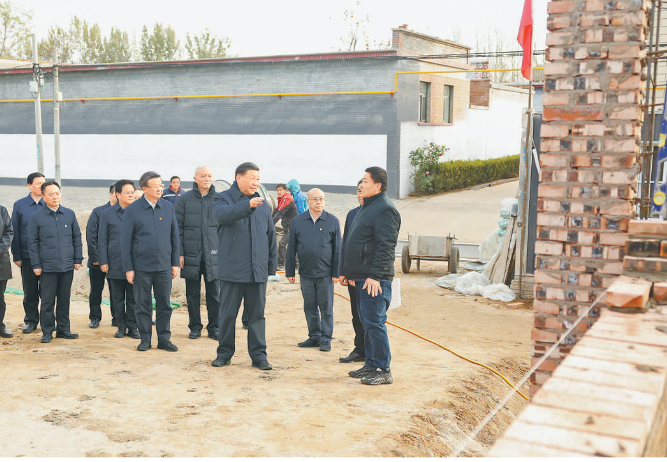
11月10日,中共中央总书记、国家主席、中央军委主席习近平在北京、河北考察灾后恢复重建工作。这是10日下午,习近平在河北保定涿州市刁窝镇万全庄村房屋重建施工现场考察。
