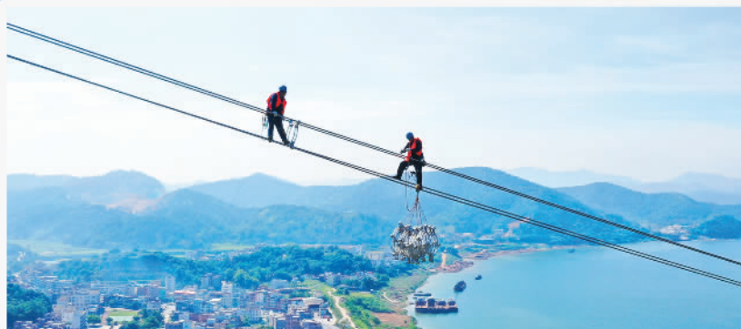
南方电网广东电网公司施工人员正在对粤港澳大湾区500千伏外环西段跨越肇庆西江河段线路的架线施工工作
