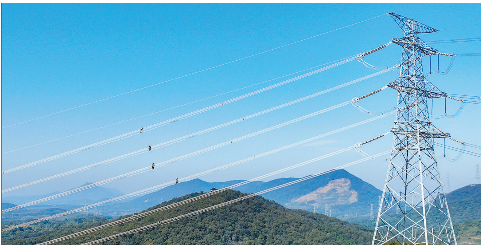
11月1日，江苏句容抽水蓄能电站500千伏送出工程验收工作正在进行。据了解，江苏句容抽水蓄能电站预计2025年建成投运，年发电量达13.5亿千瓦时，可以满足53万户家庭一年的用电量。
