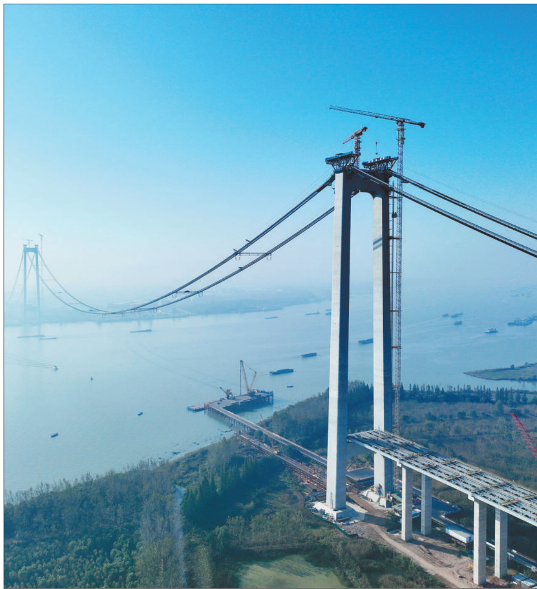
10月31日，江苏境内的龙潭长江大桥项目正加紧进行索夹和吊索安装。龙潭长江大桥设计时速100公里，全长4925米，建成后对推动扬子江城市群和宁镇扬一体化发展具有重要意义。孟德龙摄（影像中国）
