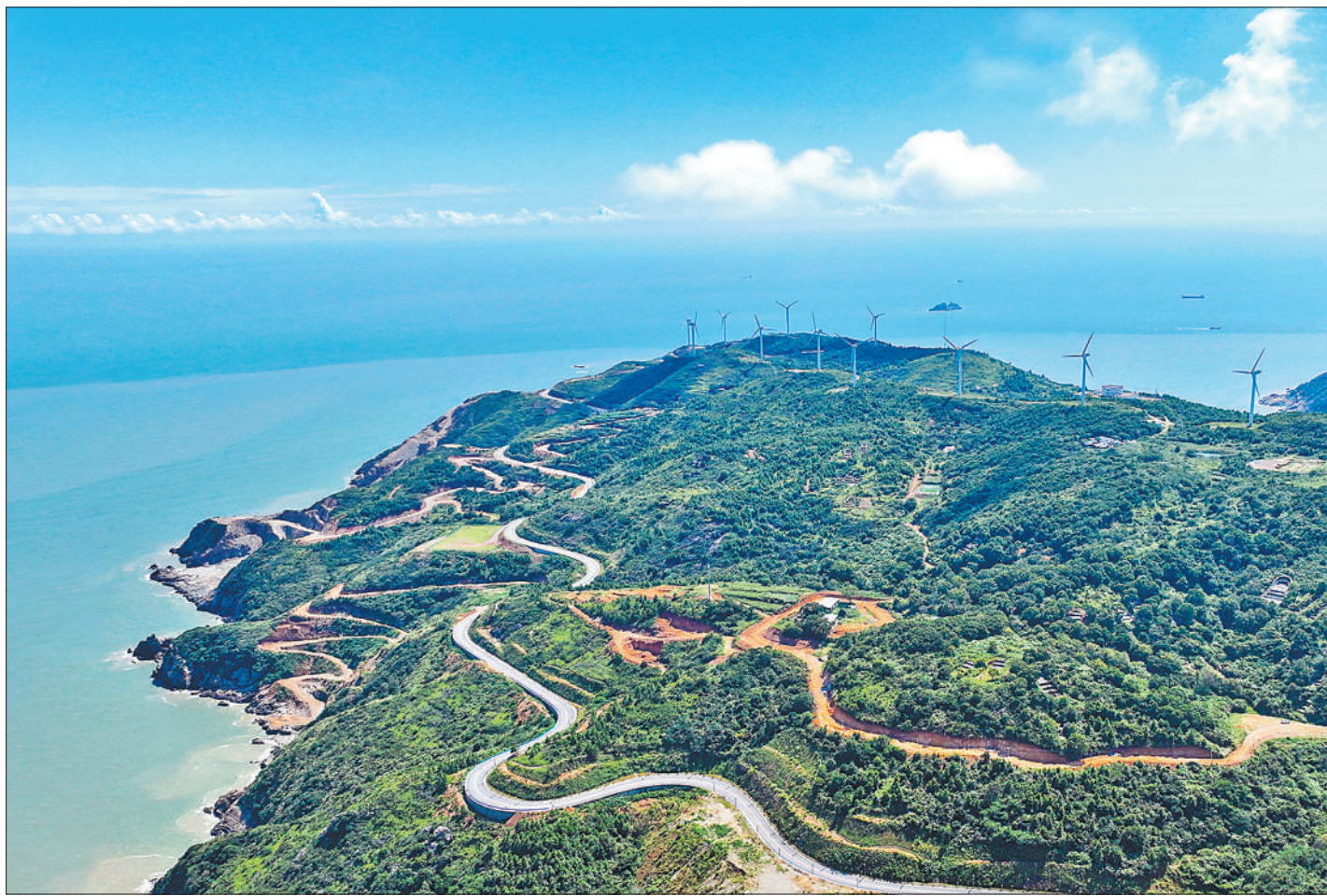
近年来，浙江省苍南县积极做好新能源发展规划建设，大力发展风、光、核电等清洁能源产业，目前县域清洁能源装机容量达110万千瓦，根据规划，到2035年将达到2300万千瓦。苍南县供电公司采取多种举措，加大技术保障力度，将绿电送往千家万户。图为苍南县群山上的风力发电机组。张维特摄(人民视觉)
