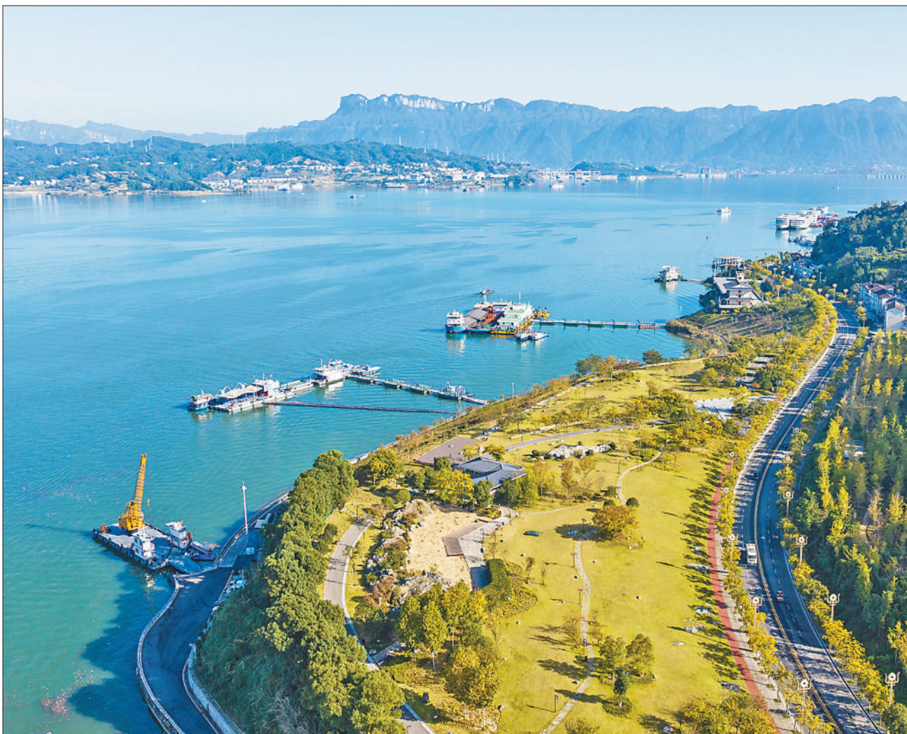
10月31日,湖北省宜昌市秭归县种归港秋景如画。近年来,秭归县实施山水林田湖草沙系统治理,修复三峡库区生态,采取库岸工程治理、岸线植绿复绿等措施,在长江两岸构筑起生态屏障。 郑家裕摄(人民视觉)
