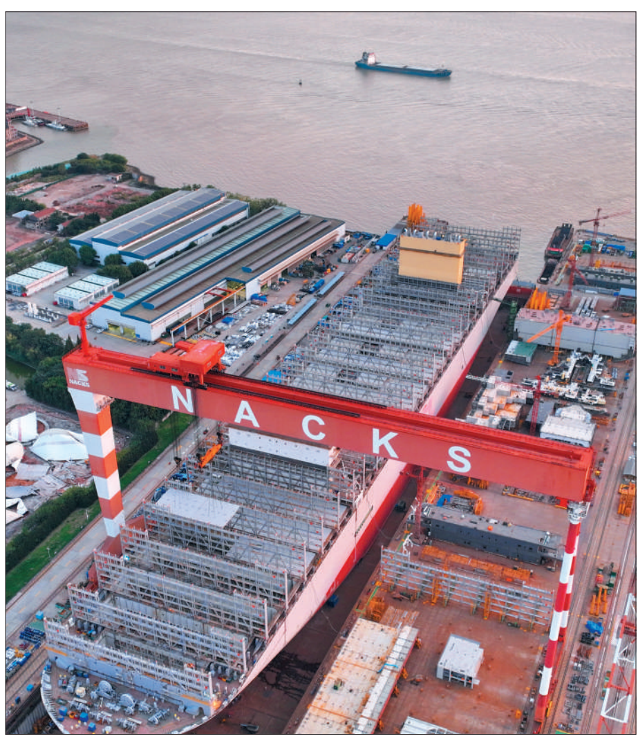
江苏南通崇川区，修造船企业忙碌的船坞、码头。 许丛军摄(人民视觉)
