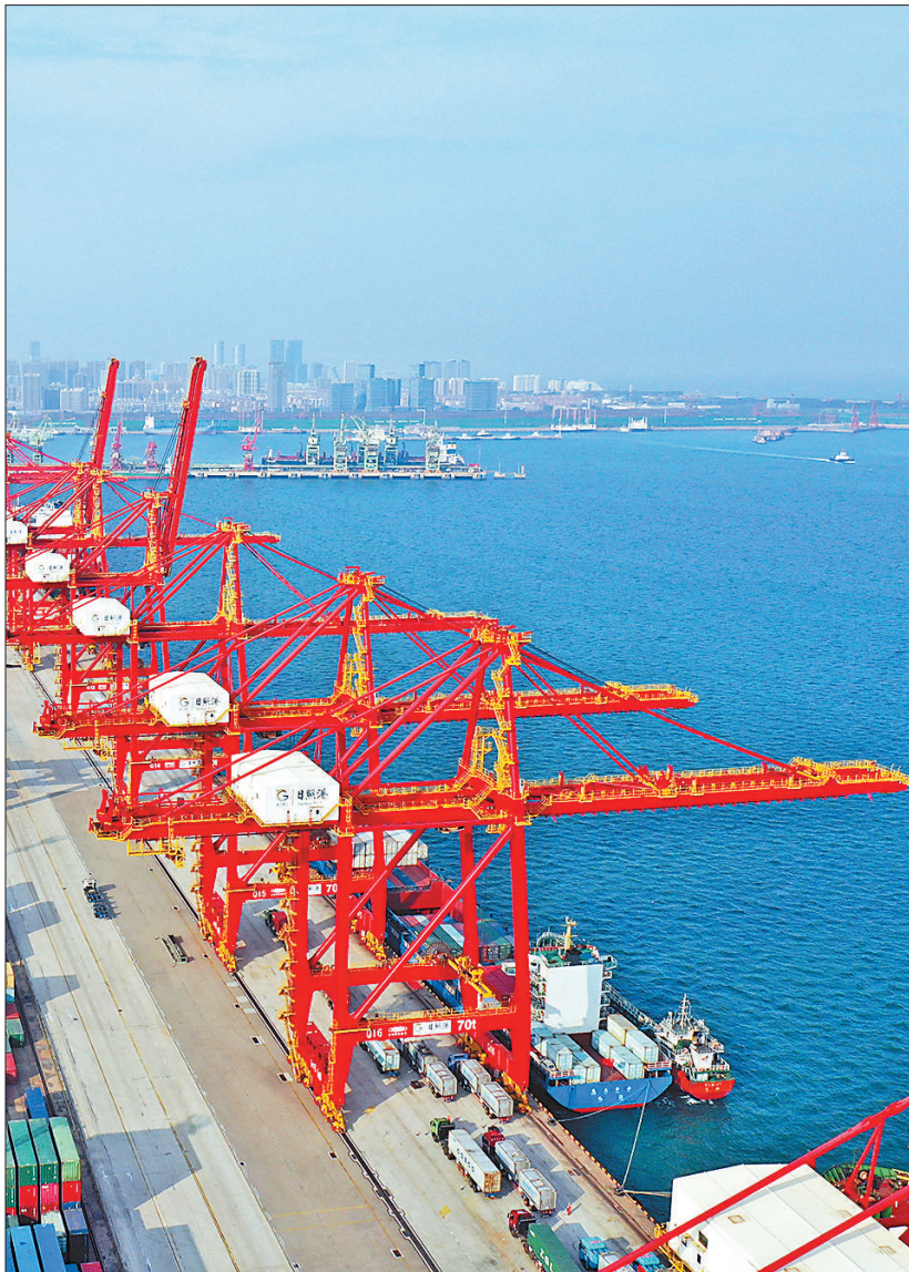
今年1至9月,山东港口日照港货物吞吐量同比增长5.7%,集装箱吞吐量同比增长7.1%,呈现出稳步向好态势。图为10月28日,日照港集装箱码头正在进行装船作业。 本报记者 陈斌摄
