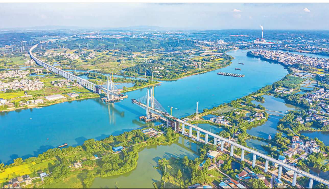
10月27日,南深高铁南玉段控制性工程——广西南宁六景都江特大桥首节钢箱梁成功安装,标志着大桥正式进入钢箱梁施工阶段。古建教摄(影像中国)
