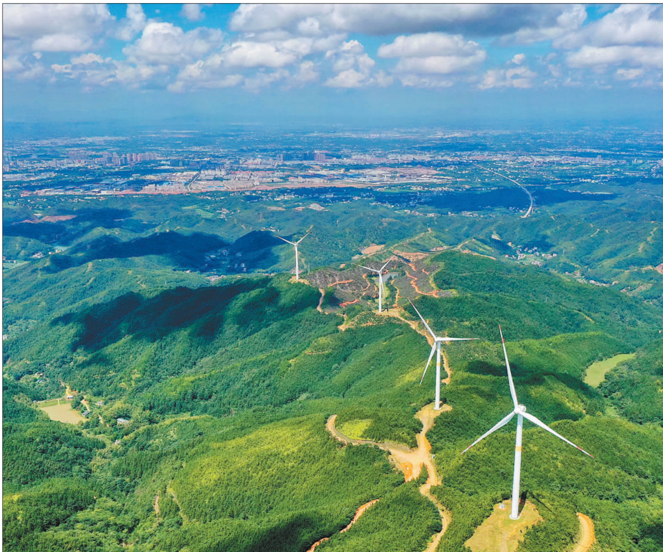
近年来，江西省赣州市坚持绿色发展，大力发展绿色清洁能源，满足当地产业发展需求，促进节能降耗、低碳减排。图为10月26日，赣州市清田风电场二期项目现场，风力发电机组矗立在绵延群山上。
