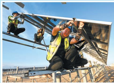
库布其沙漠新能源基地,工人正在进行光伏板安装作业。
