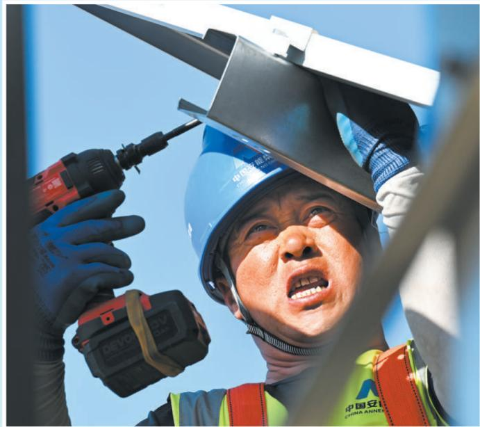
库布其沙漠新能源基地,工人正在进行组件螺栓安装作业。
