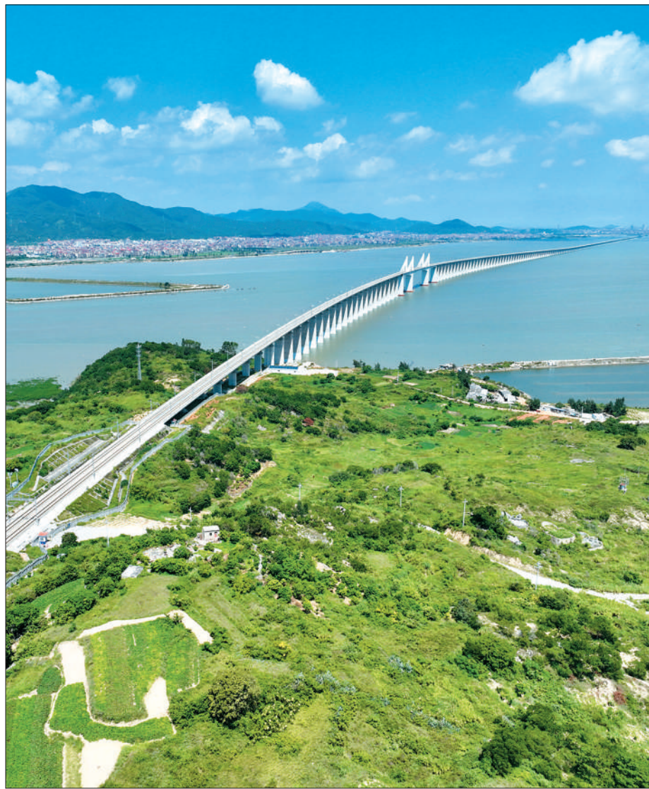
图为福厦高铁湄洲湾跨海大桥。
