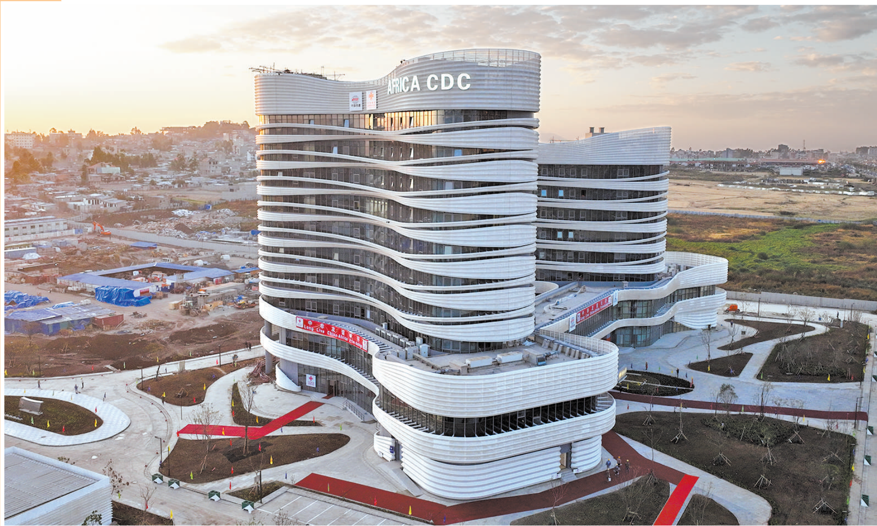
▲中企援建的非洲疾控中心总部大楼。
