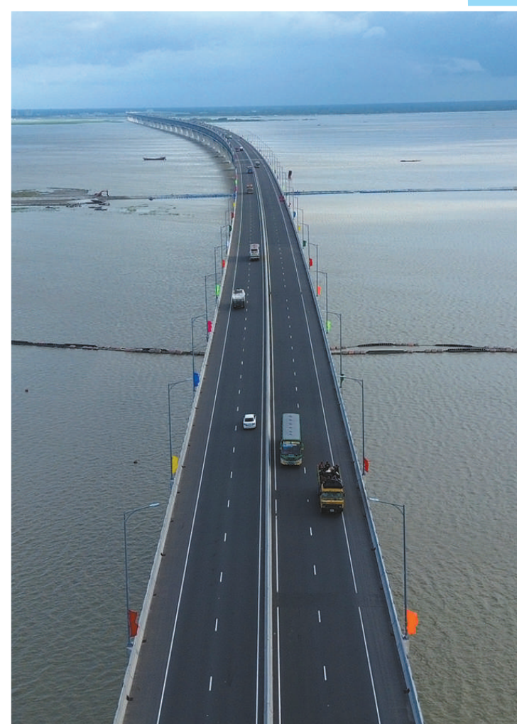
▲由中企承建的孟加拉国帕德玛大桥。
