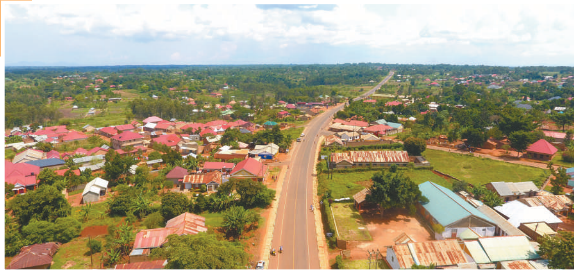
▲由中企承建的乌干达穆西塔—卢米努/布希亚—马詹基公路升级改造项目。
