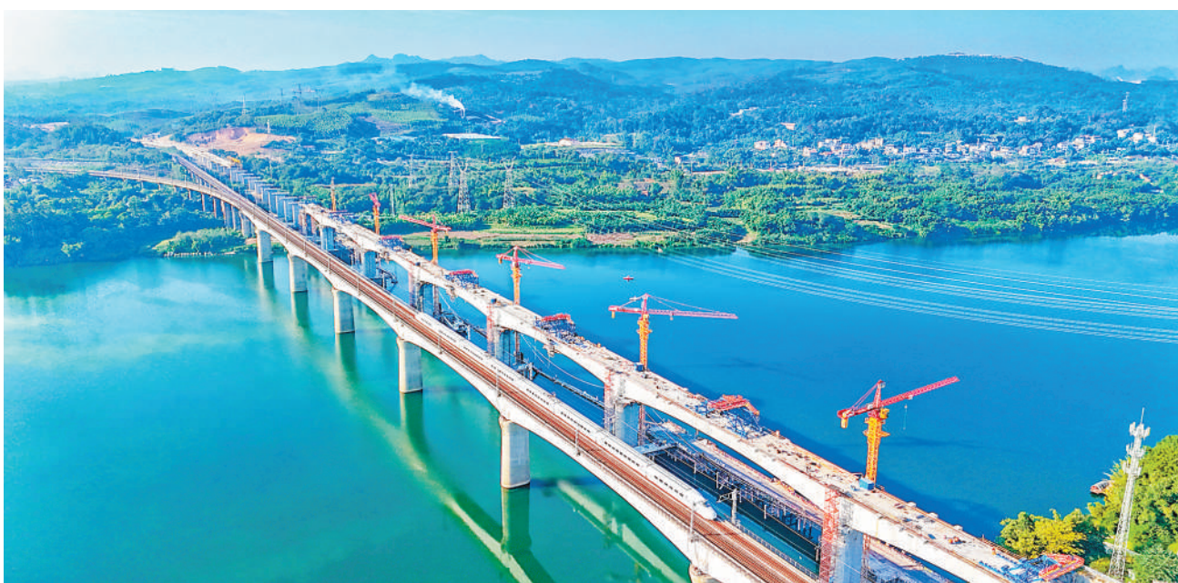
10月15日凌晨,位于广西柳州市的湘桂铁路柳江双线特大桥连续梁顺利合龙,为柳州铁路枢纽扩能改造工程实现今年年底竣工开通提供保障。柳江双线特大桥全长1688米,是湘桂铁路柳州枢纽全线的控制性工程。图为10月15日柳江双线特大桥施工现场。
