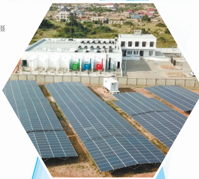
▲丝路基金参与投资的非洲加纳某数据中心。该数据中心通过光伏实现部分供电。保罗·弗兰克供图
