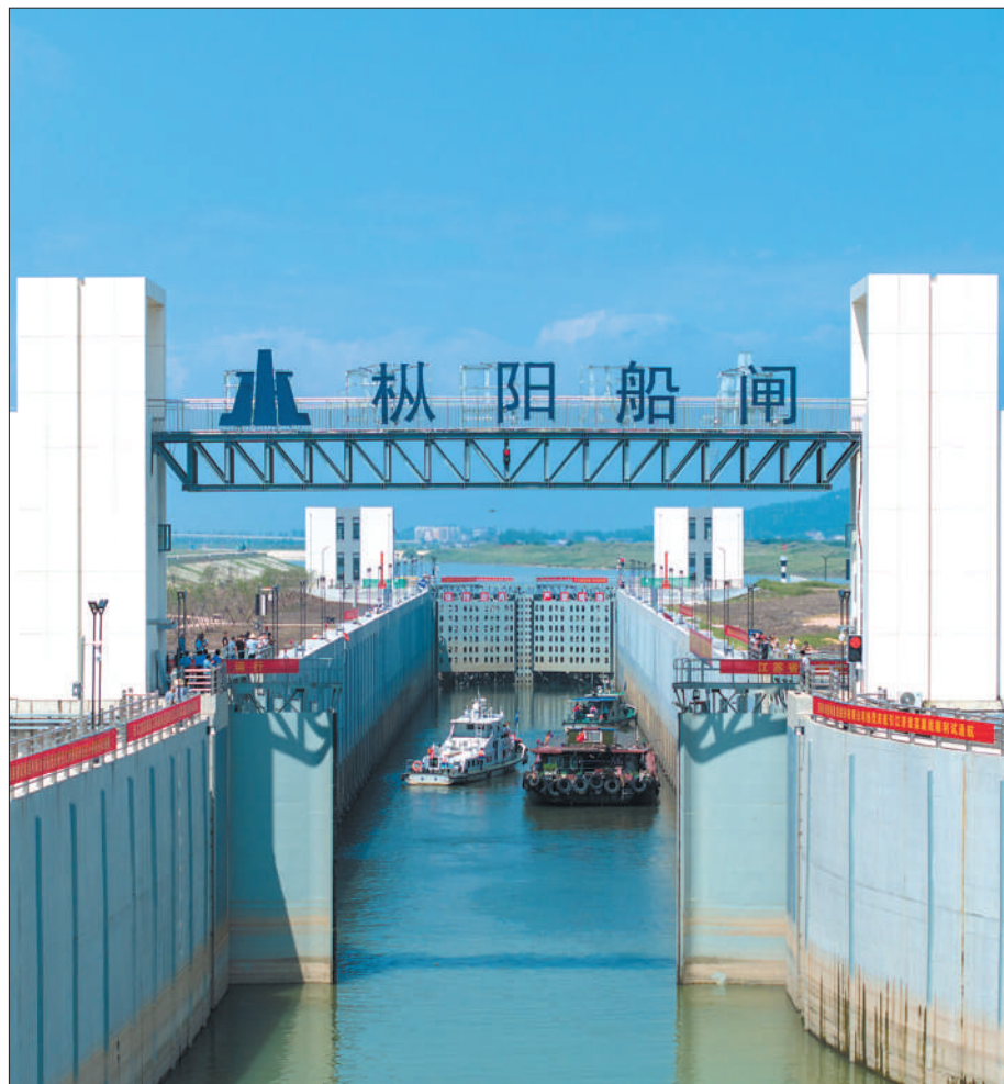
图为船只由长江进入引江济淮枞阳船闸闸室，等待通行。周啸摄（影像中国）
