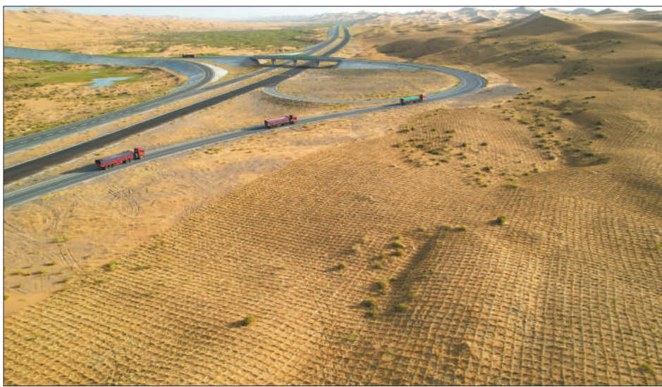
草方格阻断了流沙对阿拉善盟境内315省道的侵袭。
