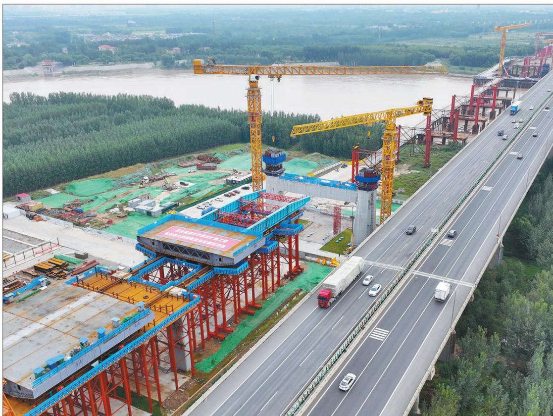
9月25日，由山东高速集团投资建设的京台高速公路济河至济南段改扩建重点控制工程黄河特大桥主桥，首节段钢箱梁完成顶推作业。济河至济南段是京台高速公路山东段改扩建工程的最后一段，为国内第一个“6+6”超车道高速公路改扩建工程。
