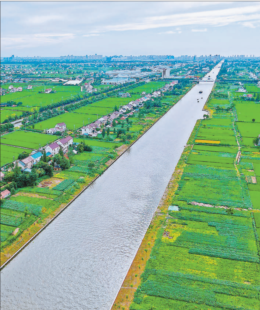
经过综合整治，通畅运河（江苏如皋段），水清岸绿，环境宜人。
