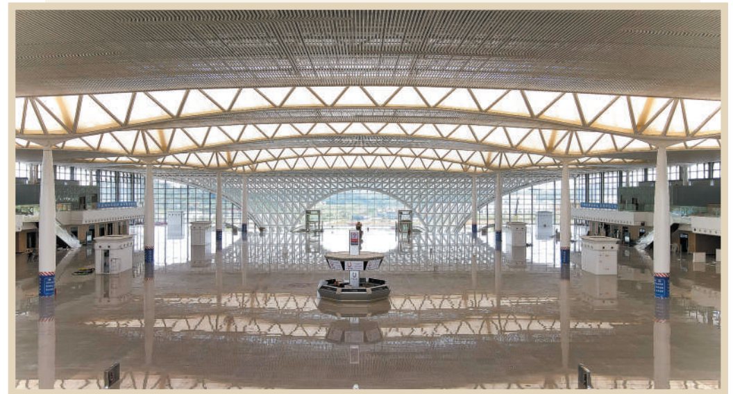
湖南益阳市是传统的竹乡,竹文化和竹制艺术历史悠久。益阳南站的进站广厅由空间编织结构支撑,象征益阳的非物质文化遗产“竹编”文化。李悦摄(人民视觉)
