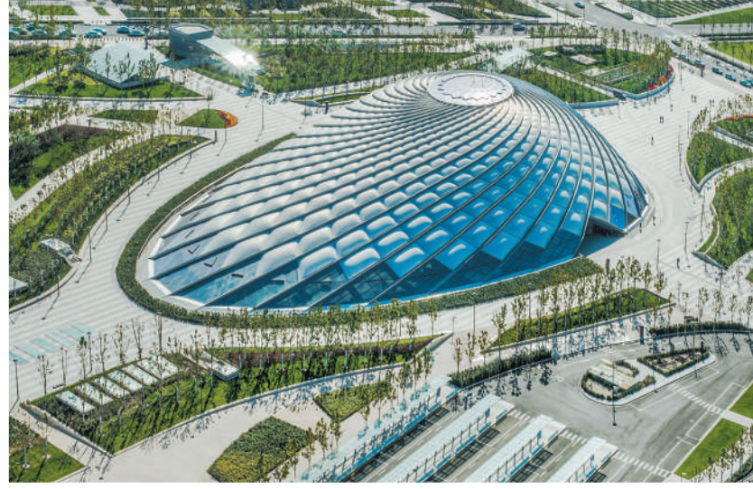
滨海站位于天津滨海新区,设计灵感源于鸚鵡螺和向日葵的螺旋线,是全球首个单层大跨度网壳穹顶钢结构工程。左上图为滨海站。右上图为车站贝壳式穹顶。图片均为杨宝森摄(人民视觉)
