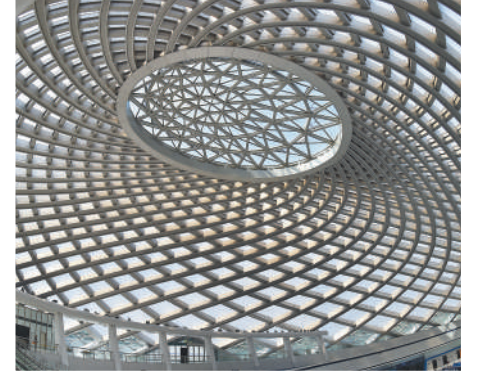
滨海站位于天津滨海新区,设计灵感源于鸚鵡螺和向日葵的螺旋线,是全球首个单层大跨度网壳穹顶钢结构工程。左上图为滨海站。右上图为车站贝壳式穹顶。图片均为杨宝森摄(人民视觉)
