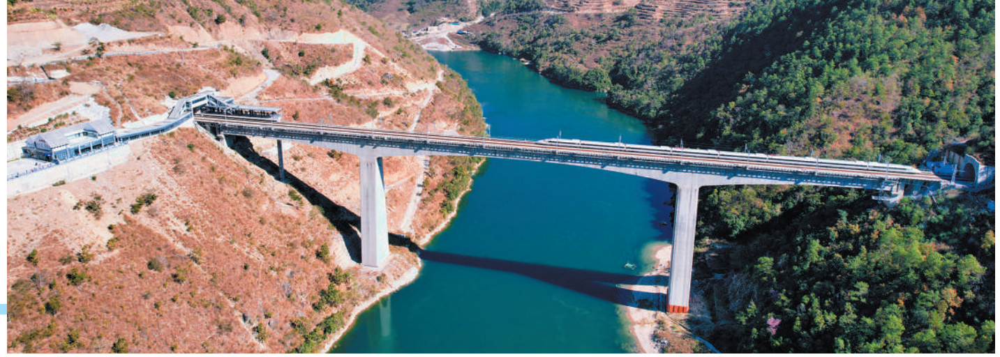
小湾东站位于云南大理白族自治州小湾东镇澜沧江畔,四周是高山、峡谷、江河,采用半隧半桥方式设计建造,一半建在隧道里,一半建在大桥上。车站是为巩固拓展脱贫成果、有效衔接乡村振兴而在已开通运营线路上新设的高铁站。图为动车驶入小湾东站。杨紫轩摄(人民视觉)
