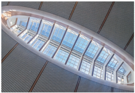
新建厦门北站装有1400平方米感应式智能天窗,可根据光照、温度、雨水等条件自动启闭,预计每年可减少二氧化碳排放14.13吨。左上图为新建厦门北站智能天窗。右上图为新建厦门北站外景。代槐子摄(人民视觉) 新华社记者 魏培全摄
