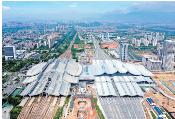
新建厦门北站装有1400平方米感应式智能天窗,可根据光照、温度、雨水等条件自动启闭,预计每年可减少二氧化碳排放14.13吨。左上图为新建厦门北站智能天窗。右上图为新建厦门北站外景。代槐子摄(人民视觉) 新华社记者 魏培全摄
