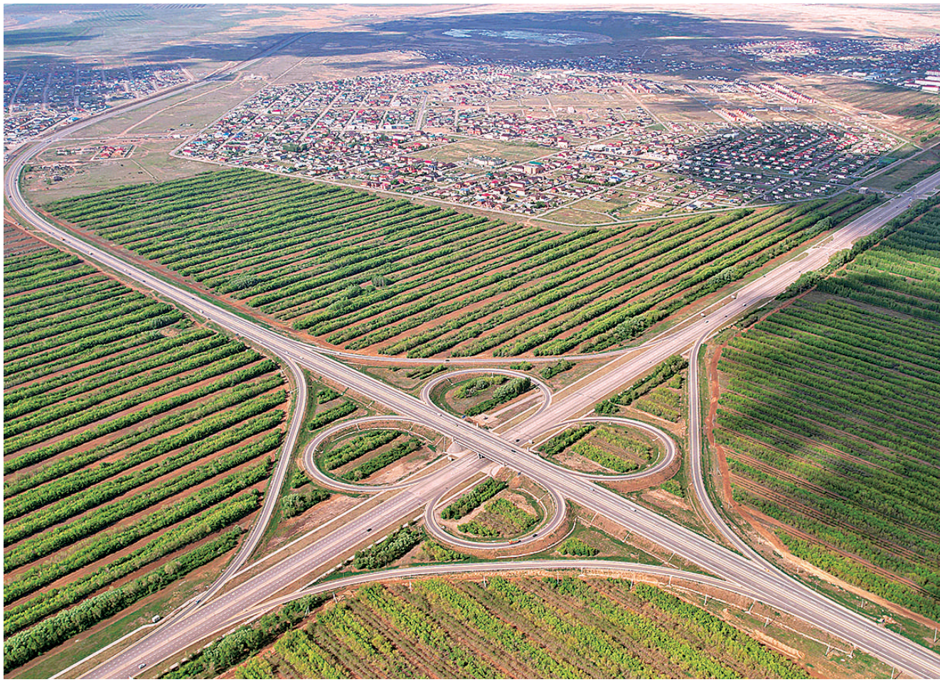
由中国进出口银行提供融资支持、中国新建设总承建的哈萨克斯坦首都阿斯塔纳西南环城公路项目，全长约34.4公里，设计时速120公里，是共建“一带一路”倡议对接哈萨克斯坦“光明之路”新经济政策的重点项目，也是哈萨克斯坦国家道路交通网的重要工程。项目通车后大幅提高了阿斯塔纳交通系统效率，在节约行驶时间的同时，也有利于改善生态环境。 王晓亮摄
