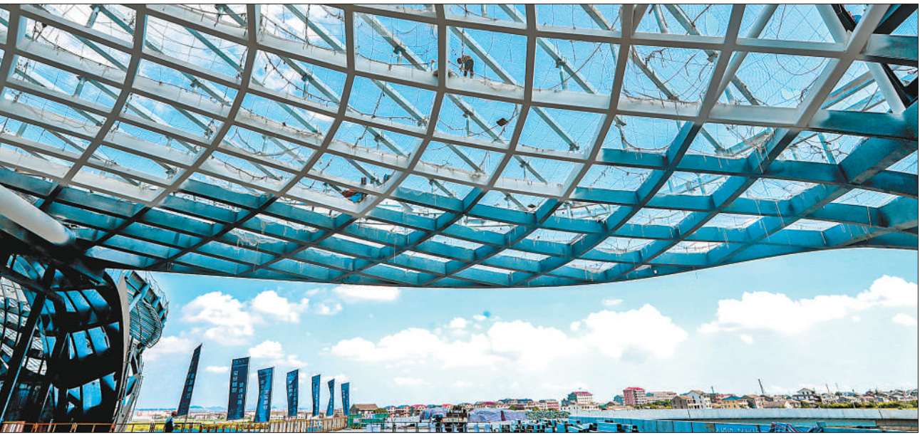
9月19日，在浙江省台州机场改扩建项目航站楼施工现场，工人们正在加紧施工。目前，航站楼进入全面装修阶段。孙金标摄（影像中国）
