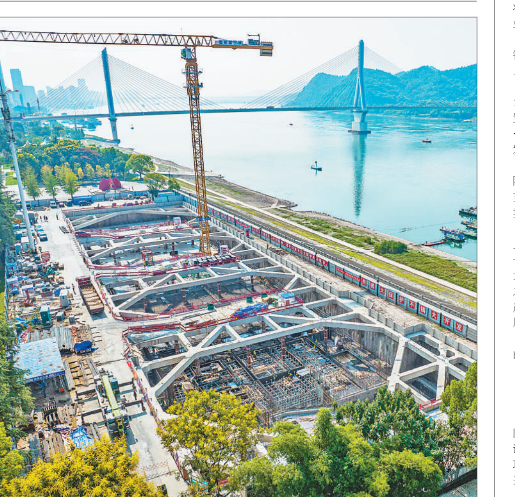
9月17日，湖北省宜昌市“两江两岸”污水厂网新建、改扩建项目大石桥调蓄池正在施工。近年来，宜昌等长江沿岸城市加紧水环境综合整治工程建设，通过城镇污水治理、岸线生态修复、兴建“公园式”污水处理厂、城市智慧管网管控、补齐雨水污水管网短板等措施，全链条推进城市水环境治理。新华社记者 肖艺九摄
