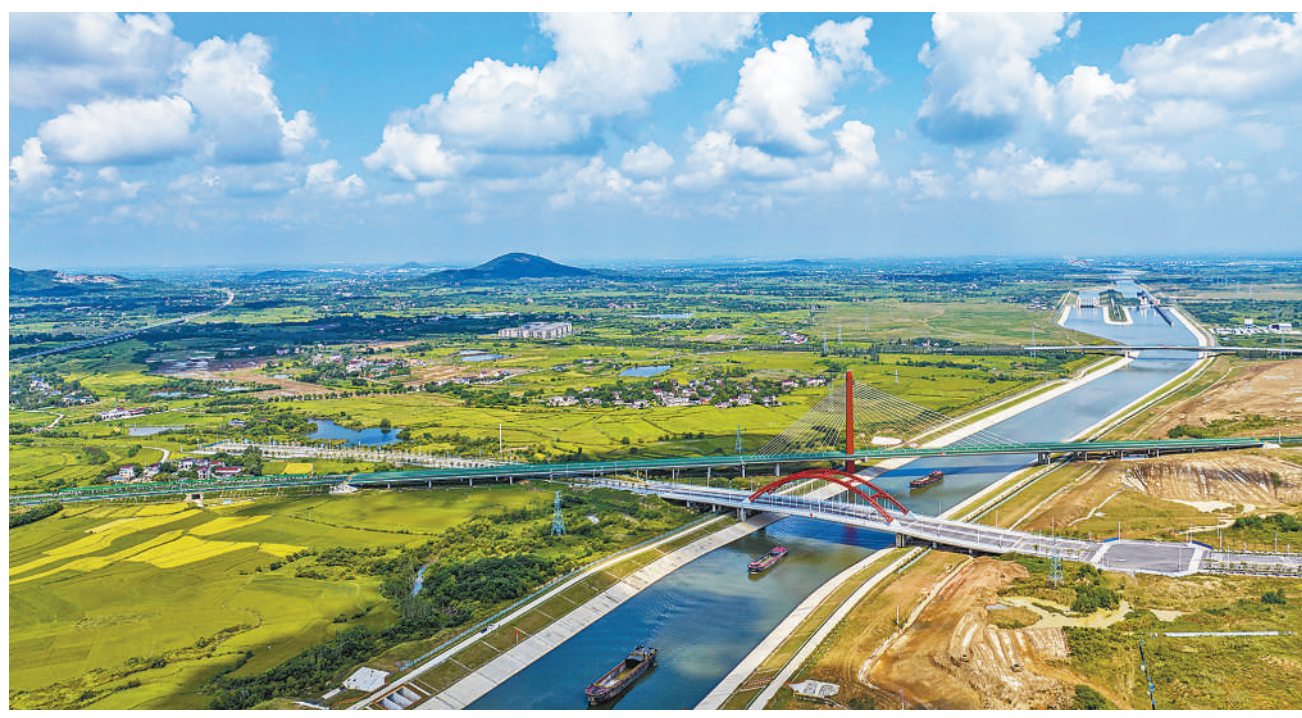
9月16日，位于安徽省的引江济淮工程枞阳小港及菜子湖线航道开启试运行，标志着连通长江与淮河的江淮运河已全线贯通。江淮运河是平行于京杭大运河的南北水运大通道，航道总里程约355公里。图为当日，安徽省合肥市庐江县，船只行驶在江淮运河上。 左学长摄(影像中国)
