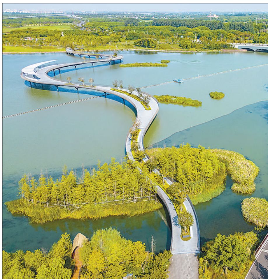
江苏省苏州市吴江区元荡慢行桥周边，水清岸绿，林木葱翠。
