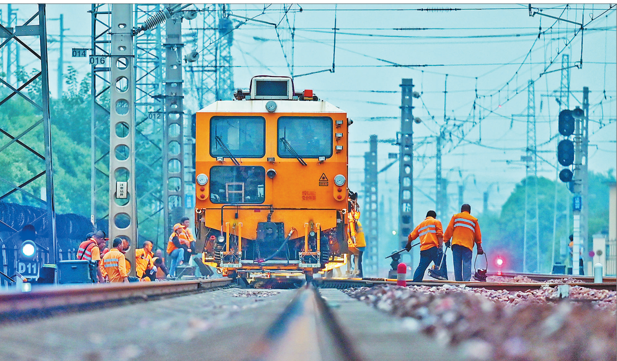
9月11日,京广铁路秋季集中修启动。中国铁路郑州局集团有限公司计划对管内京广铁路的线路、道岔、桥梁及供电接触网等设施进行全面检查整修,为中秋、国庆假期旅客运输安全奠定基础。图为京广铁路广武站集中修施工现场,大型养路机械车正在对道岔进行捣固作业。王玮摄(影像中国)
