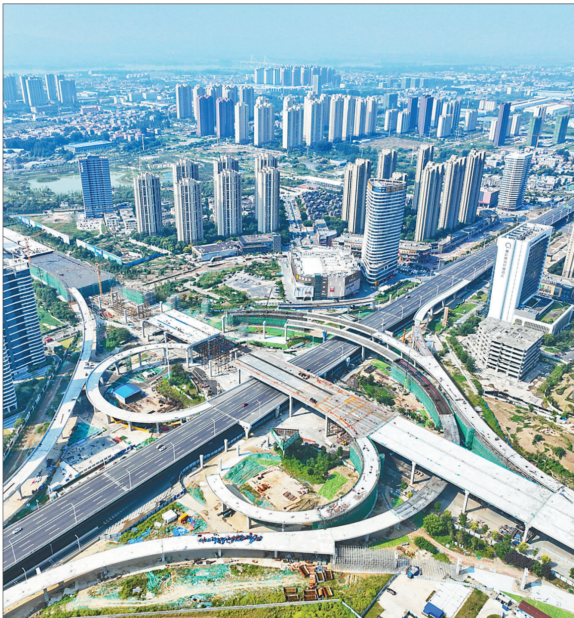
跨襄江大道立交桥是湖北襄阳环线提速改造二期的重点工程,建成后将有效提升交通效率,方便群众出行。图为湖北襄阳跨襄江大道立交桥施工现场。 谢勇摄(影像中国)
