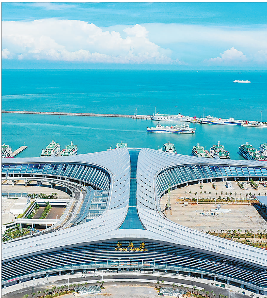
海南海口，新海滚装码头客运综合枢纽站项目正在进行收尾工作。康登林摄(影像中国)
