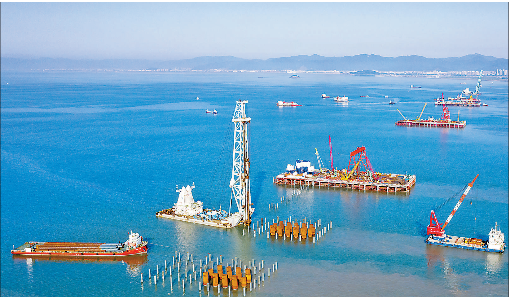
9月10日，浙江宁波舟山港六横公路大桥二期工程正在施工。据了解，宁波舟山港六横公路大桥二期工程建成后，将为浙江新增一条跨海大通道，有力促进六横、佛渡港区及临港产业基地的发展，实现六横岛、佛渡岛、梅山岛三岛港区、产业等联动发展。章勇涛摄（影像中国）
