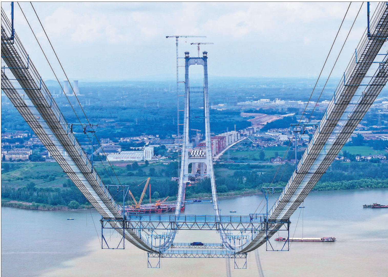
近日，位于江苏境内的龙潭长江大桥上部结构施工主缆中央通风管道全部安装完成，将有效解决桥梁主缆除湿防腐难题，提升耐久性和使用寿命。龙潭长江大桥预计2024年年底建成，建成后对推动扬子江城市群和宁镇扬一体化发展具有重要意义。图为9月6日，建设中的龙潭长江大桥。方东旭摄(影像中国)
