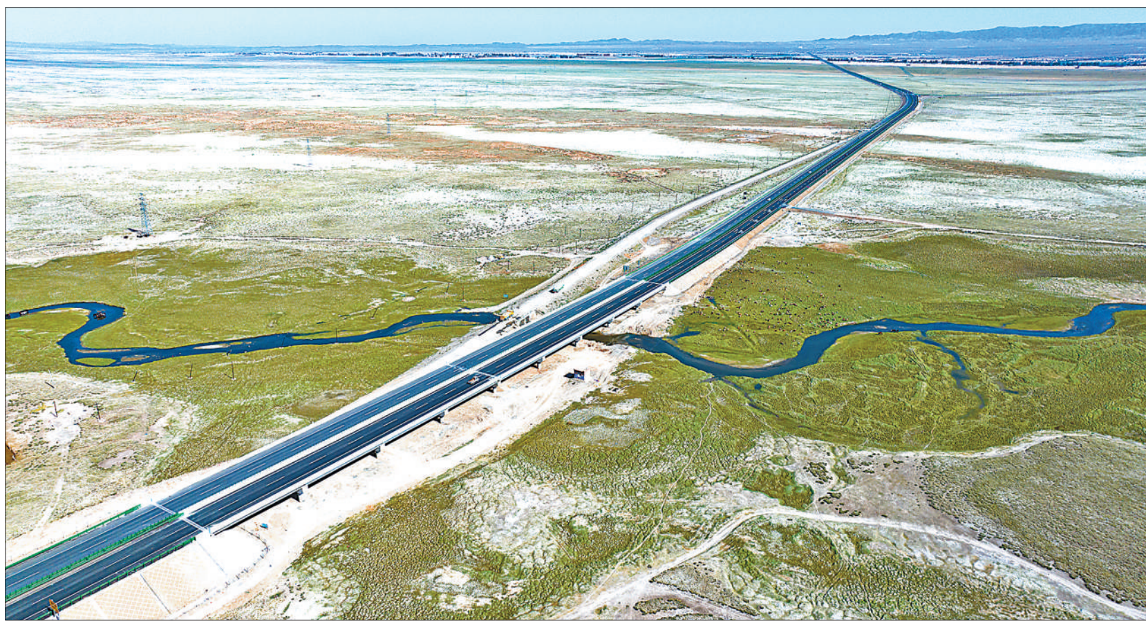
近日，由中交一公局集团投运的新疆G575老爷庙口岸至巴里坤公路二期工程建成通车。至此，G575老爷庙口岸至巴里坤公路（G575老巴公路）全线建成通车。G575老巴公路是贯通天山南北交通大通道的重要组成部分，穿越湿地草原、雪岭云杉，从戈壁荒漠连通村居农庄。开通后，巴里坤县城到老爷庙口岸的车程由3个小时缩短至1.5小时左右。韩鑫 杜雅娟摄影报道
