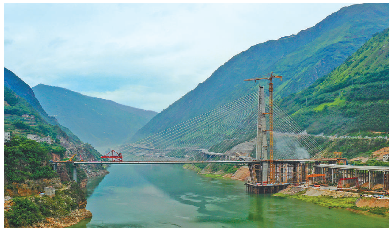
横跨金沙江、连接四川和云南两省的都香高速金沙江特大桥9月1日顺利合龙，主桥全面贯通，大桥建设转入桥面系施工。金沙江特大桥主塔高197.6米，全长565米，主跨跨径340米，是国内最大跨径钢箱混凝土梁独塔斜拉桥。大桥建成后，将有利于推动西南地区经济社会发展。图为都香高速金沙江特大桥合龙作业现场。
