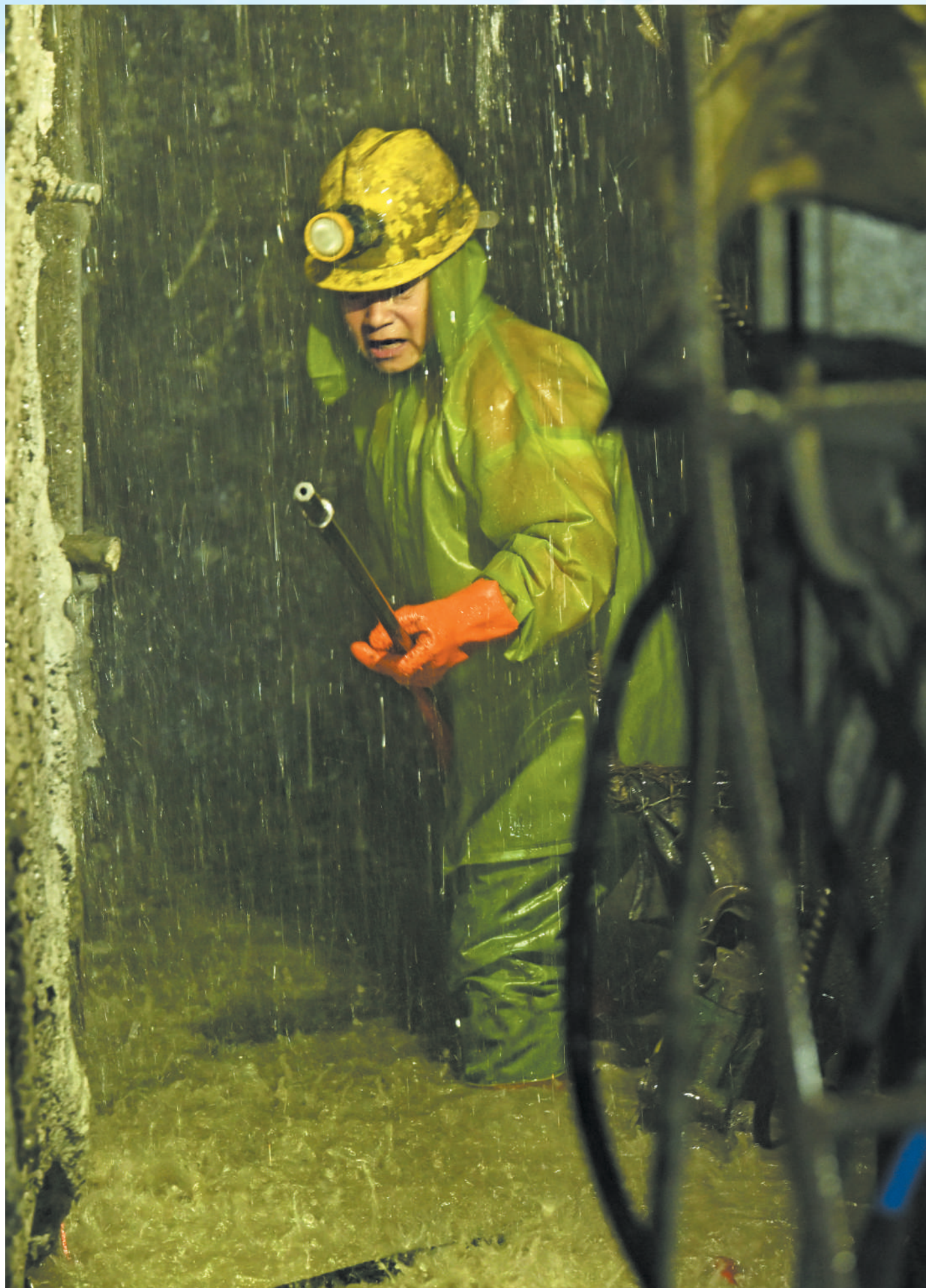
引汉济渭二期工程南干线黄午隧洞11号支洞控制段，工人冒着滴水掘进施工。
