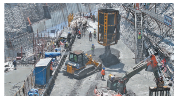
工人在东庄水利枢纽大坝导流底孔用吊罐下料浇筑混凝土。
