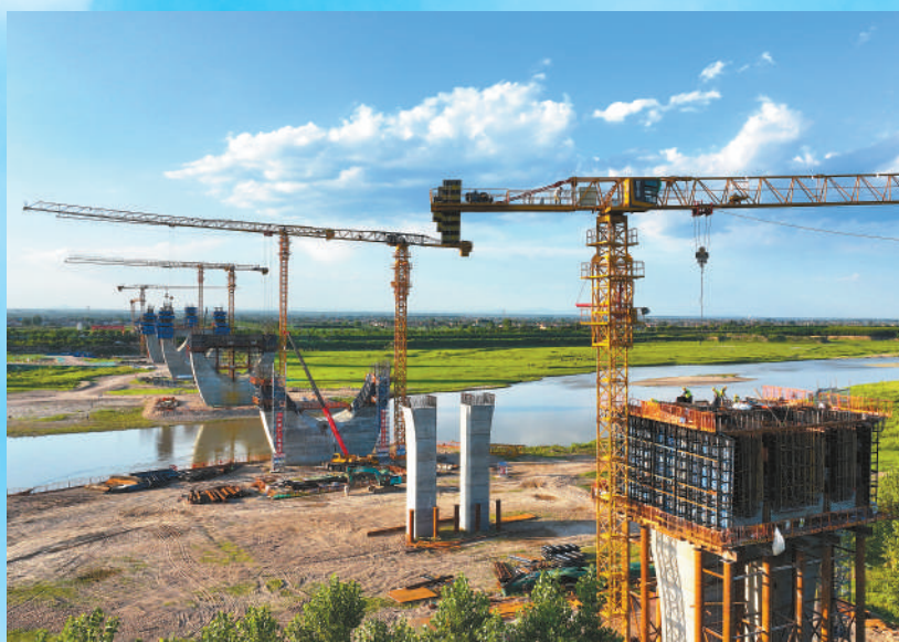
引汉济渭二期工程输水线路渭河管桥施工现场。
