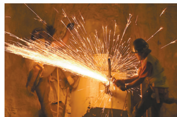
东庄水利枢纽施工现场，工人挑灯夜战。
