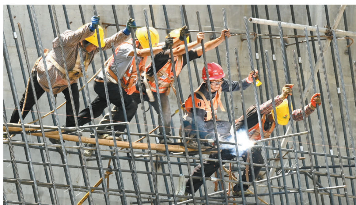
工人在东庄水利枢纽左岸护塘边坡混凝土护坡焊接钢筋。
