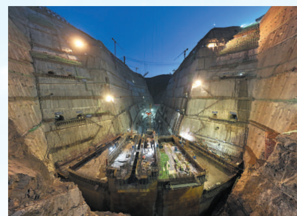
东庄水利枢纽施工现场。
