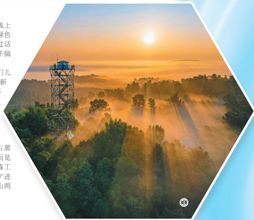
图①：伊春森工集团的一处防火瞭望塔。
