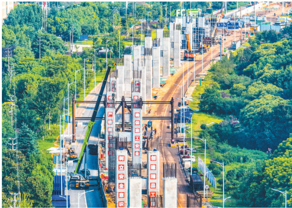
在安徽省繁昌经济开发区快速化通道改造工程现场,施工人员有序施工作业。 鲁君元摄(人民视觉)
