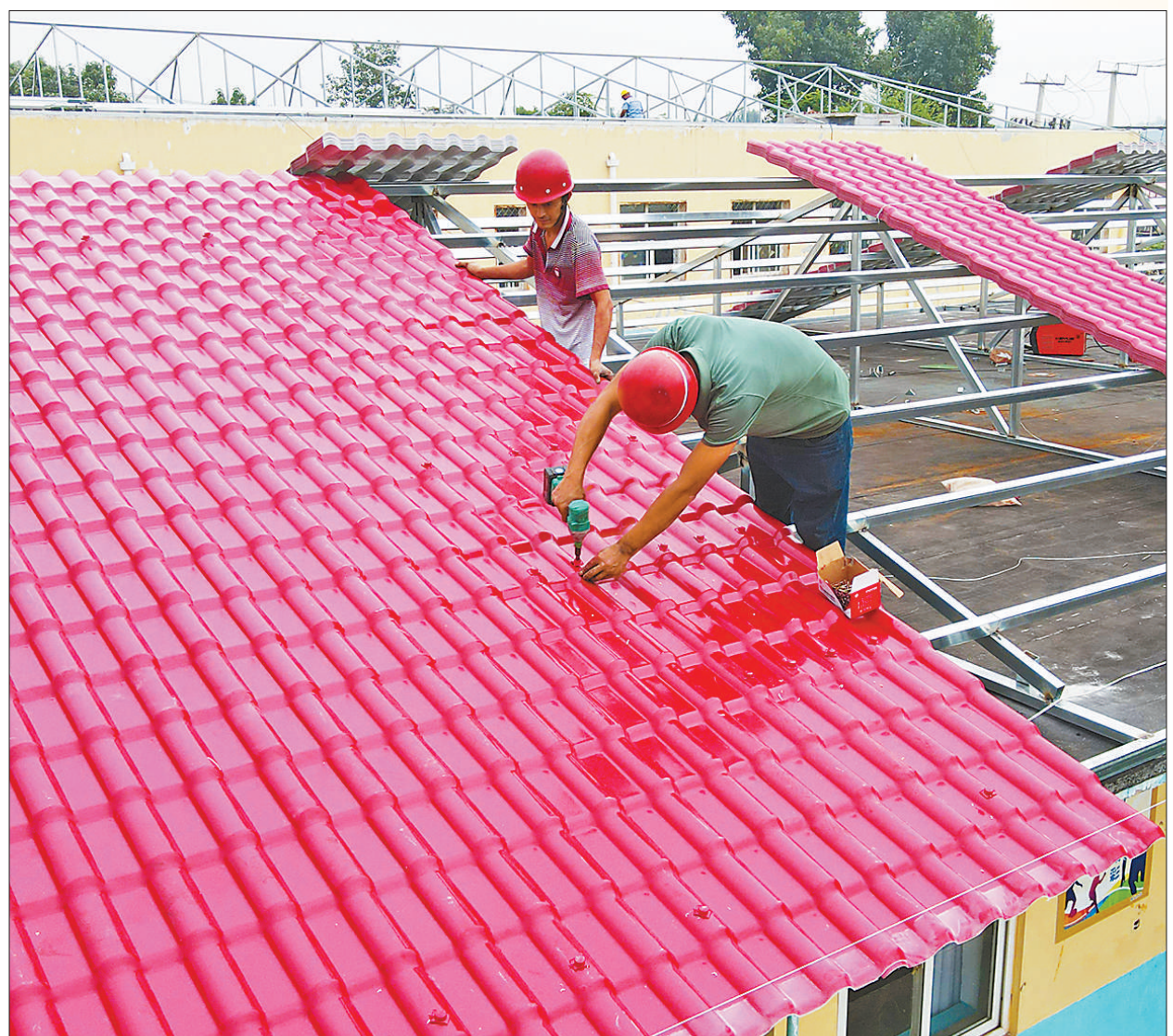
8月25日，在河北省临城县都庄小学，工人在教学楼顶安装树脂瓦。连日来，临城县加快推进受灾学校修复重建工作，确保按时开学。 邵玉姿 赵永辉摄影报道
