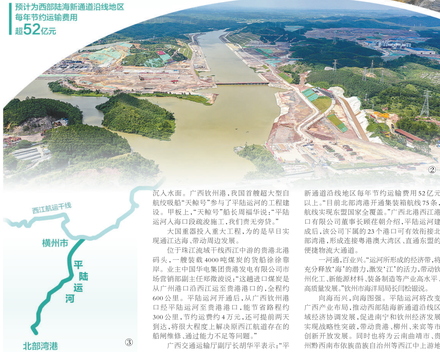
①平陆运河马道枢纽建设现场。 ②建设中的平陆运河青年枢纽。 ③平陆运河地理位置示意图。
