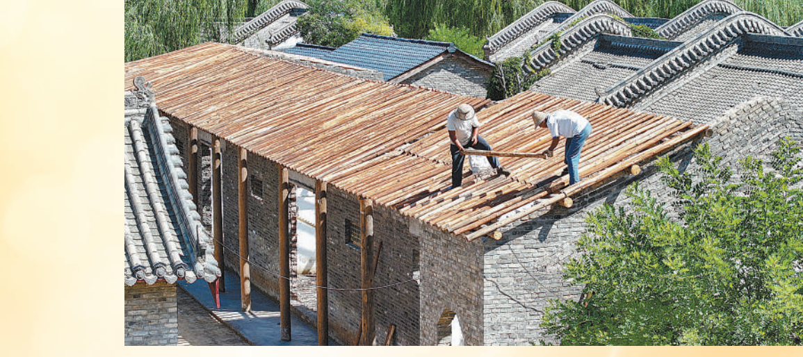
▲8月22日，在河北省邢台市信都区邢襄古镇景区，施工人员在修复受损的仿古建筑。
