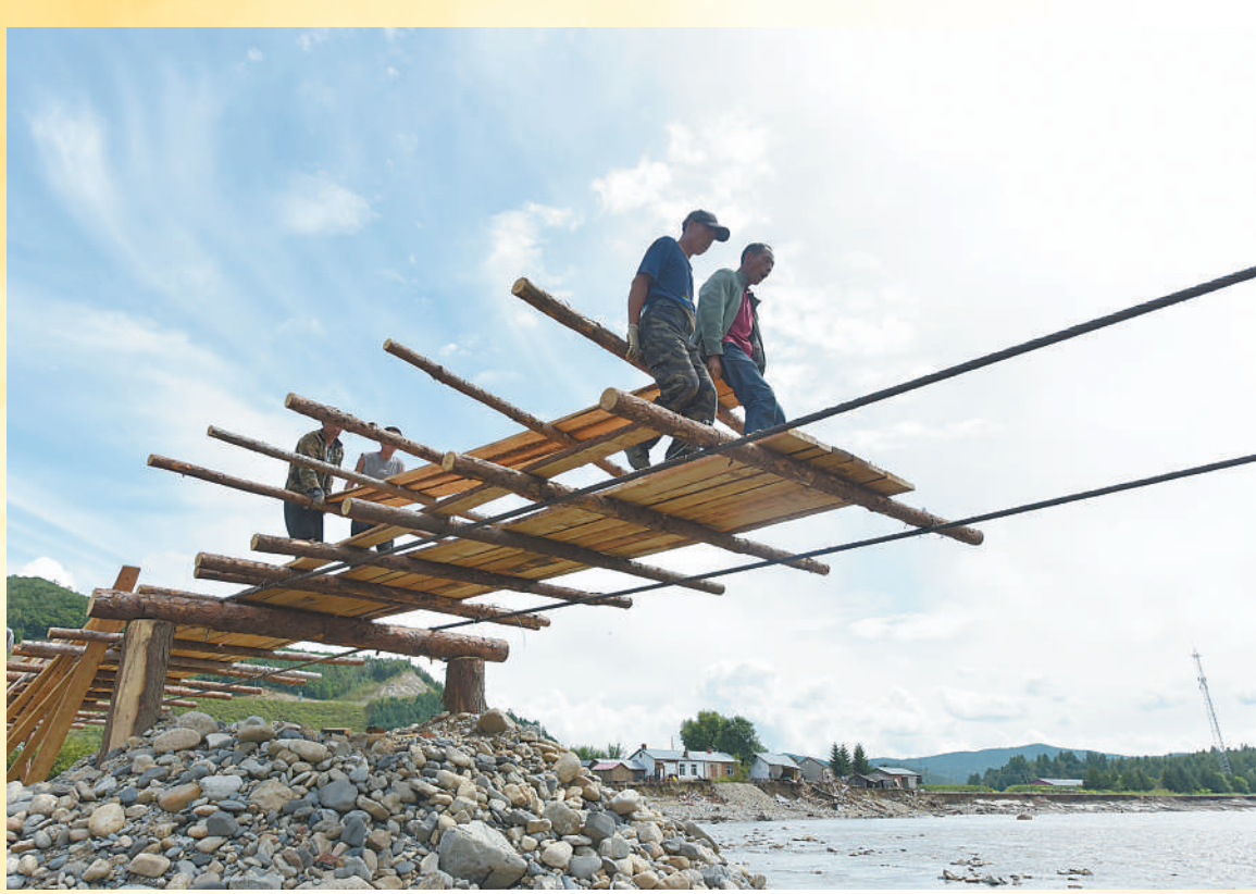
▲8月23日，在黑龙江省海林市长汀镇，当地的农民抢修队正在架设简易木桥，开展灾后重建施工作业。
