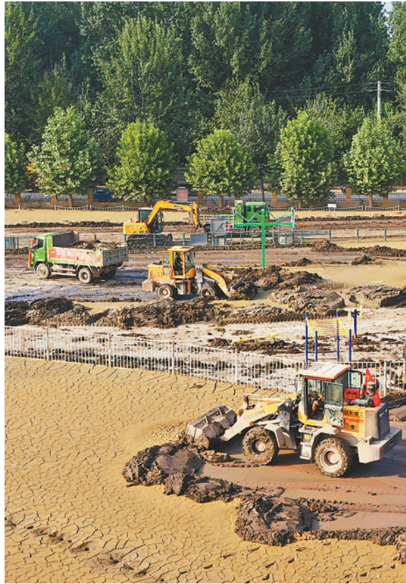
8月19日,河北省涿州市体育中心,多台机械车辆在清理淤泥。熊华明摄(人民视觉)
