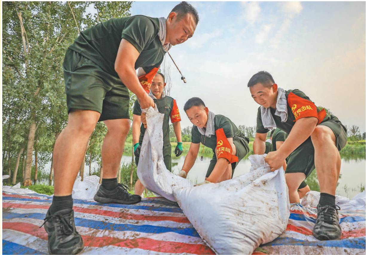
日前,武警天津总队机动支队在大清河天津段加固堤坝。8月18日7时,大清河洪水红色预警降为橙色预警。当地进一步落实主体责任,组织力量继续做好风险隐患排查。胡润润摄(人民视觉)
